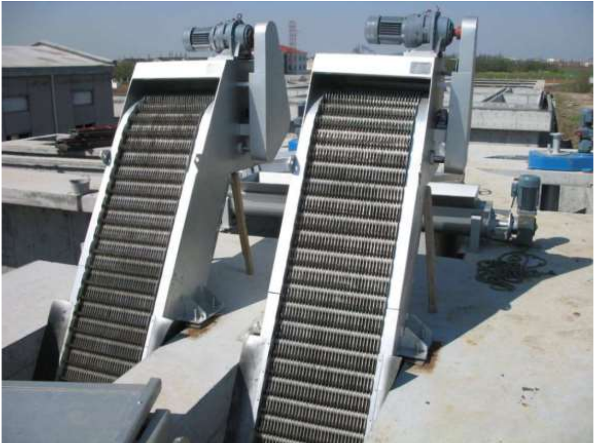
图 7.2-16 格栅除污机外形图
