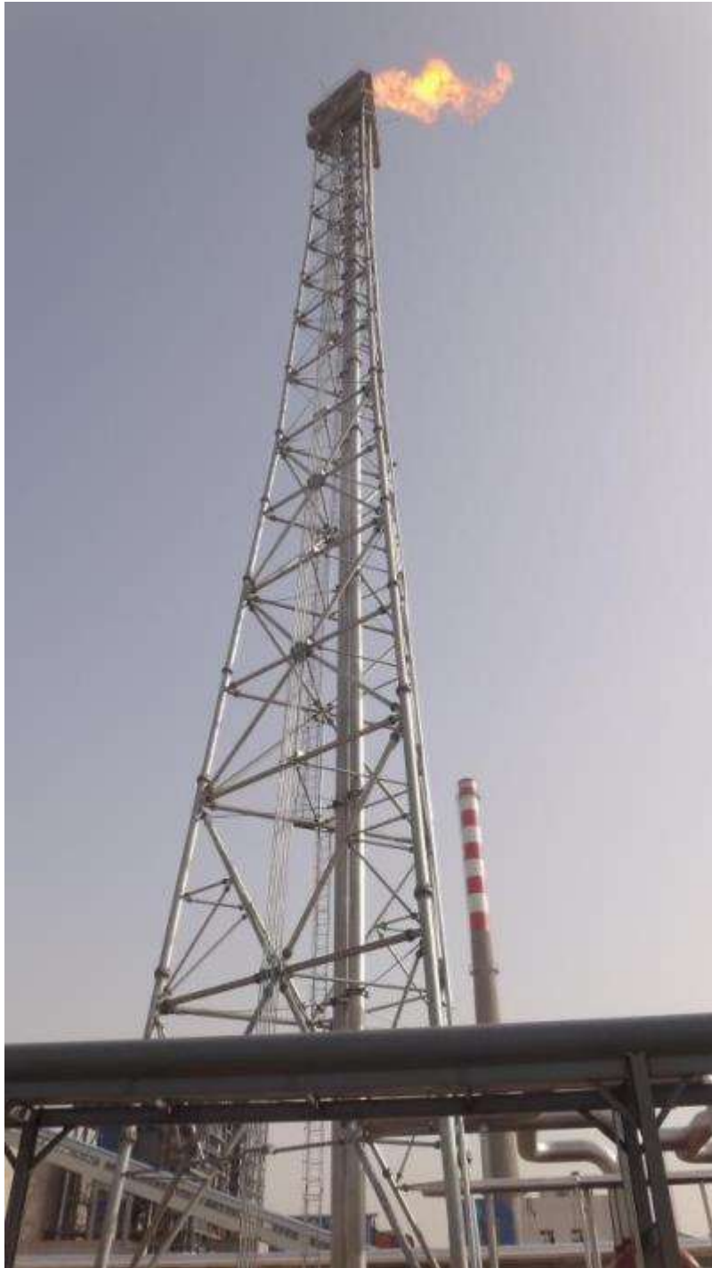
图 7.2-13 火炬燃烧系统外形图
